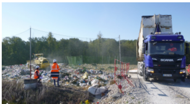
Contrôle visuel sur site par les inspecteurs de la DREAL
